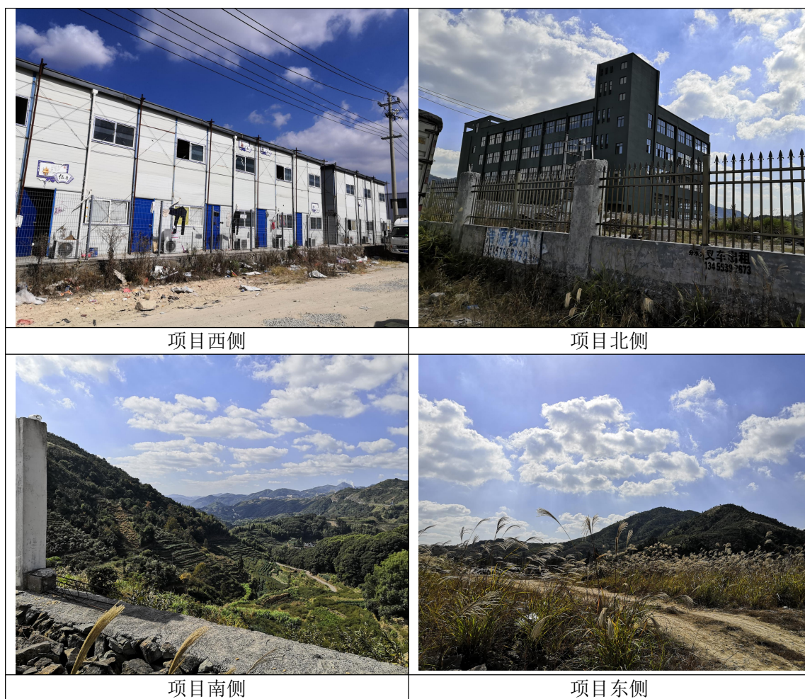
图 3.1-3 项目现场照片
