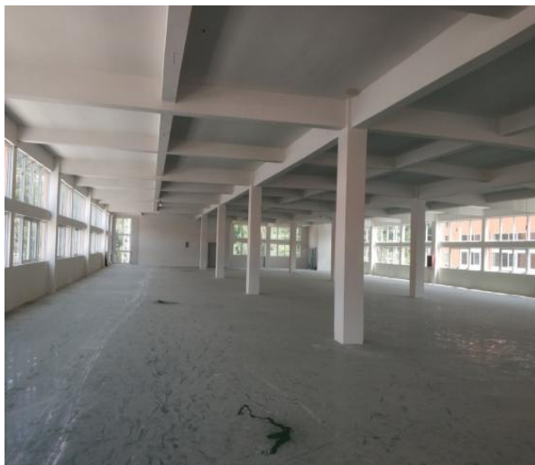
本项目厂房内部
