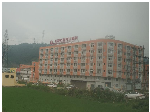
小微园项目西面
