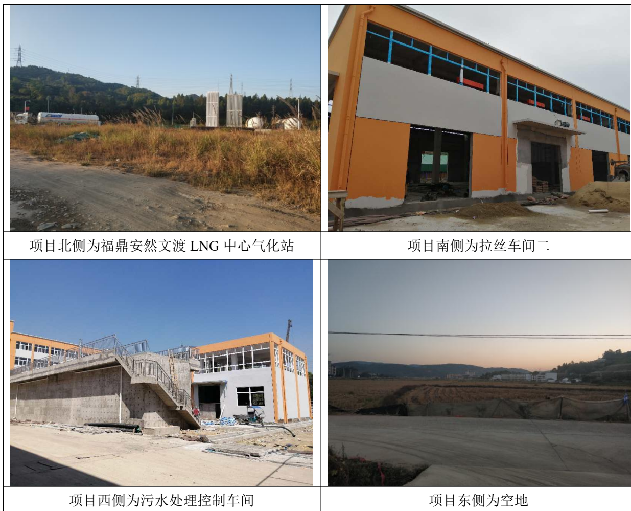
图 3.1-3 项目周边现场照片
