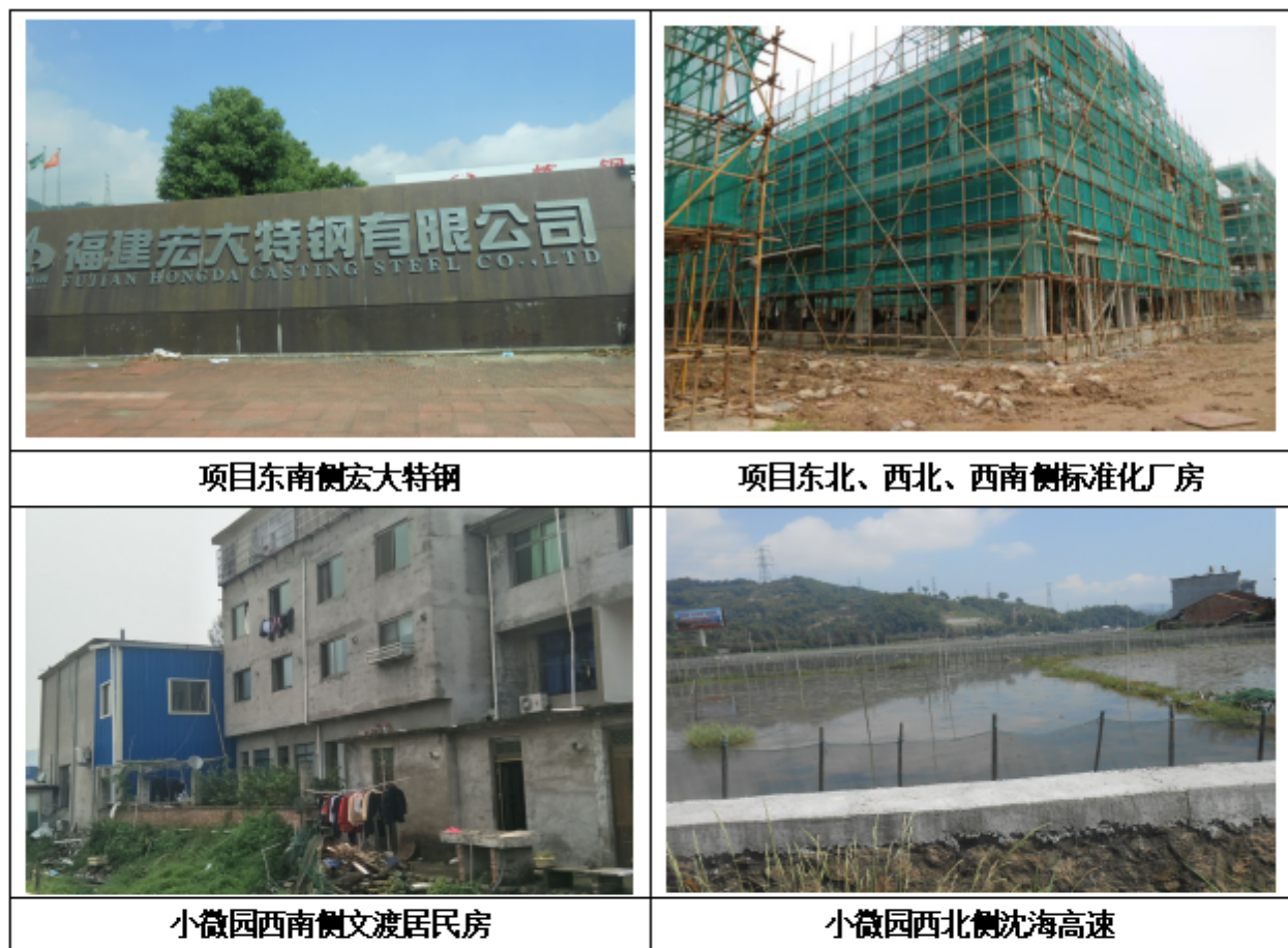
图 3.1-3 项目周边现场照片
