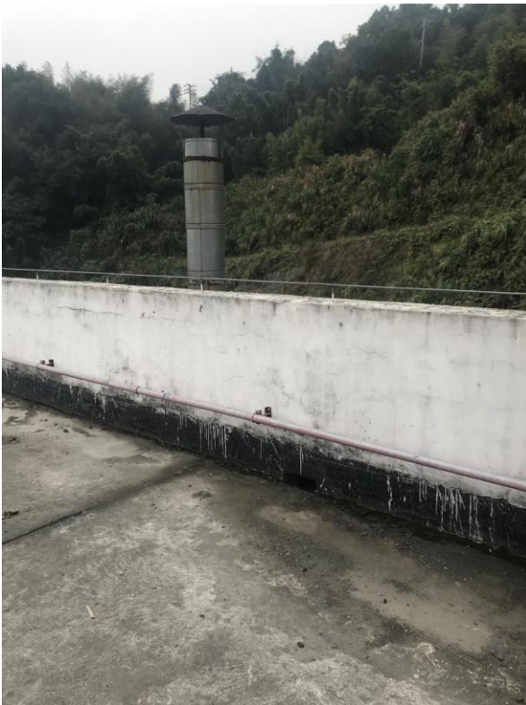
压铸机排气筒
