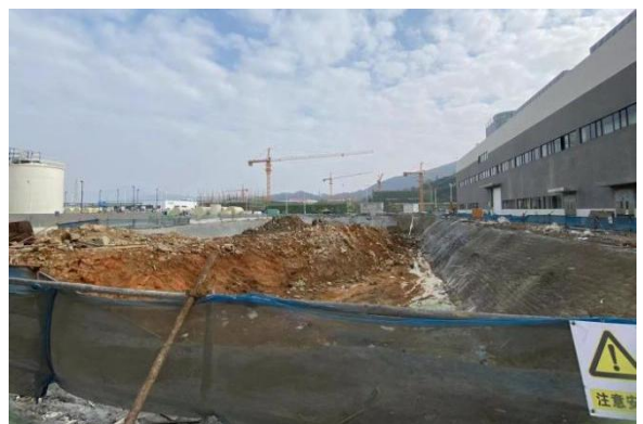
在建初期雨水池
