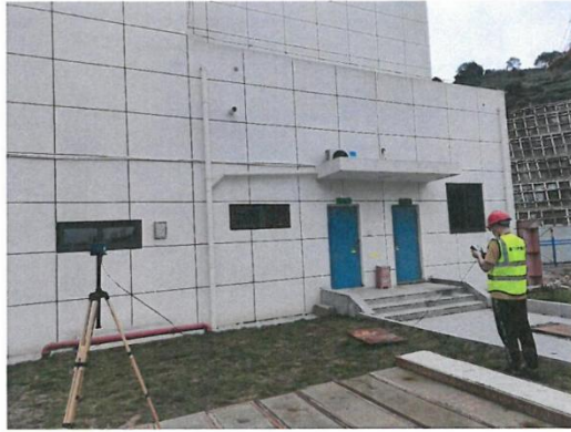
4#变电站东侧围墙外 5 m
