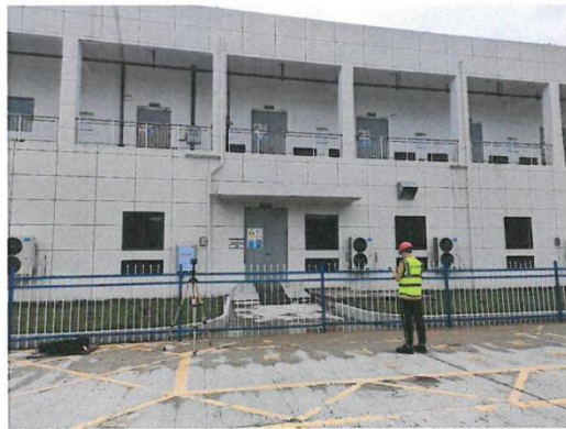
3#变电站南侧围墙外 5 m
