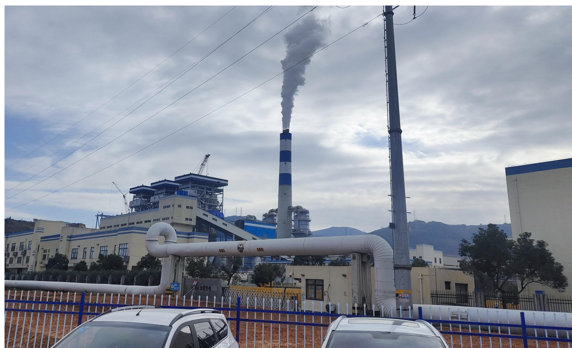
图 4.2 福鼎热电厂厂区外供汽管线
